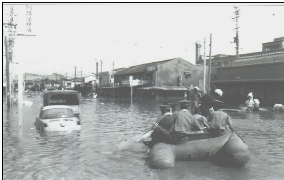
道路の冠水(兵庫区)
